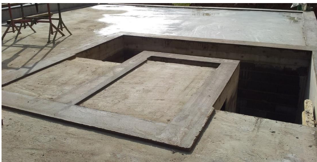
Abbildung 12: Bevor die holzius Wandelemente montiert werden, wird eine Ausgleichsschicht erstellt.
