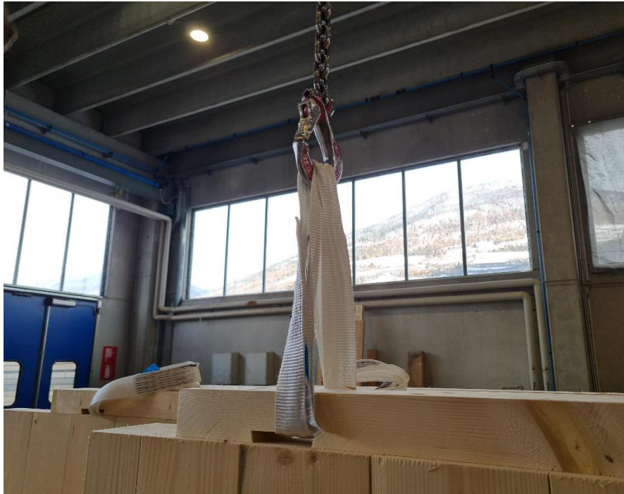
Abbildung 5: An den Wandelementen sind Transporthölzer angebracht, an denen die Einwegschlaufen eingefädelt werden.
