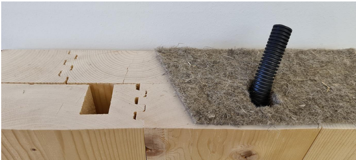
Abbildung 17: Die Öffnung im Hanfdämmstreifen ermöglicht es dem Elektriker die Rohre durchzuziehen.
