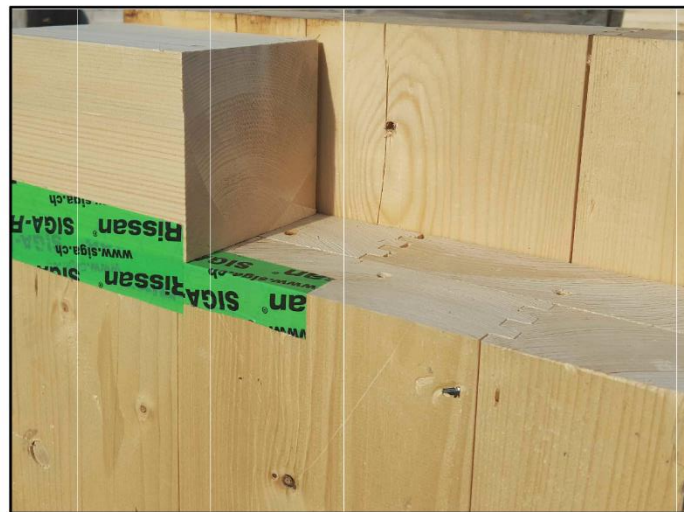
Abbildung 18: Luftdichter Anschluss, bauteilübergreifend und ohne Hanfstreifen.
