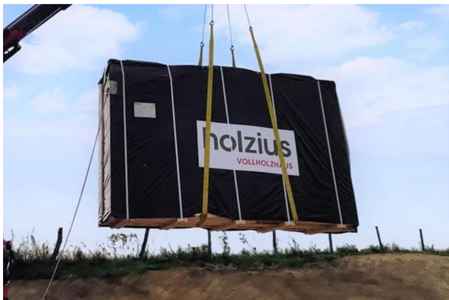
Abbildung 4: Mit Hebegurten wird das Wandpaket angehoben und an den vorgesehenen Lagerplatz gestellt.
